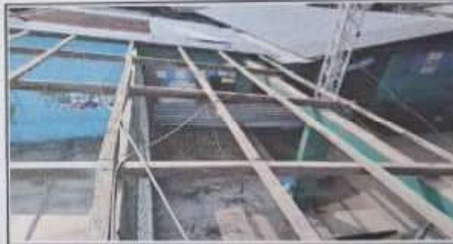
Foto 4: sustitución de lamina por lamina troquelada calibre 26, y sustitución de de soporte de metal por metal
